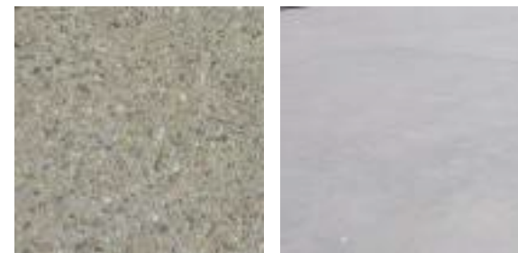
Revêtement minéral dur : béton lisse et désactivé
