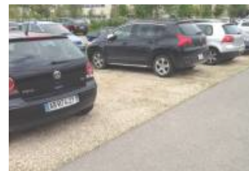
Revêtement semi-perméable pour le stationnement
